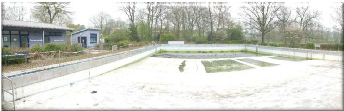
Abbildung 1: Blick auf das Schwimmbecken (April 2017)
