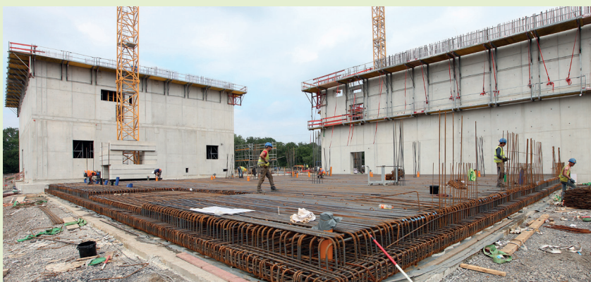
Fundamentarbeiten für das Betriebsgebäude
