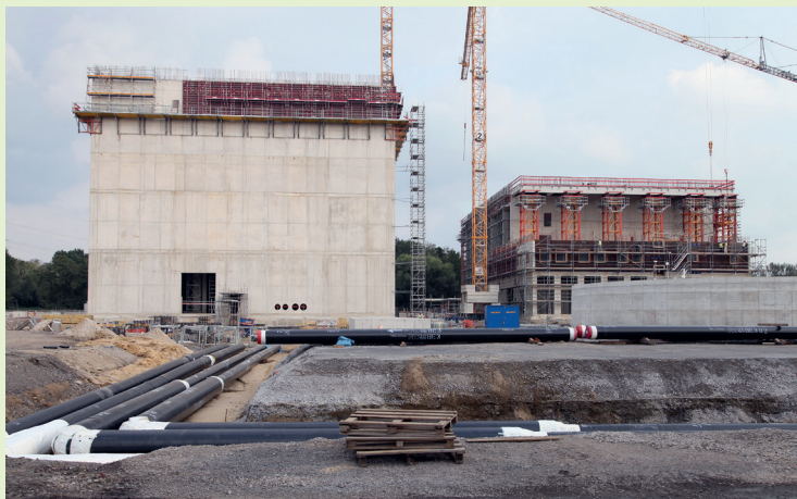
Fernwärmeleitungen liegen bereit für den Anschluss
