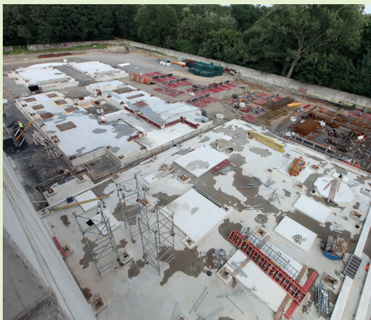
Fertige Fundamente für SCR-Gebäude, Gewebefilter und Kesselhaus
