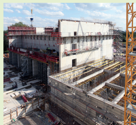
Baufortschritt – Brennstofflager und Betriebsgebäude
